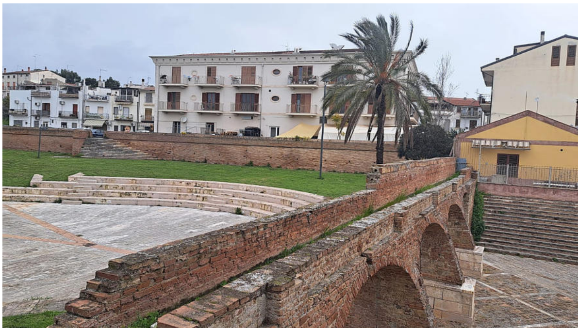
Particolare del condotto dell'acqua sul ponte-acquedotto del castello. Convogliava nell'area del castello le sorgenti del Varatizzo
