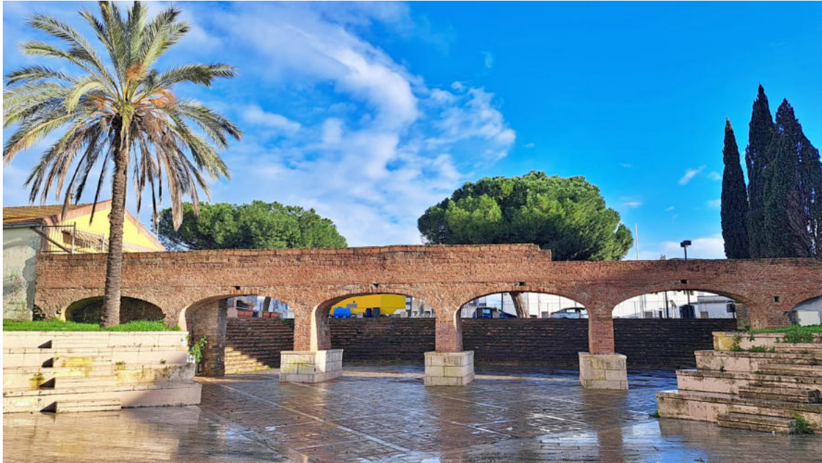
Ruderi del ponte canale dell'acquedotto del castello presso i Giardini Murati (seconda metà del XVIII secolo), forse realizzato durante l'amministrazione del feudo da parte dei Gesuiti, come la Fontana del Varatizxo (A.D. 1750)
