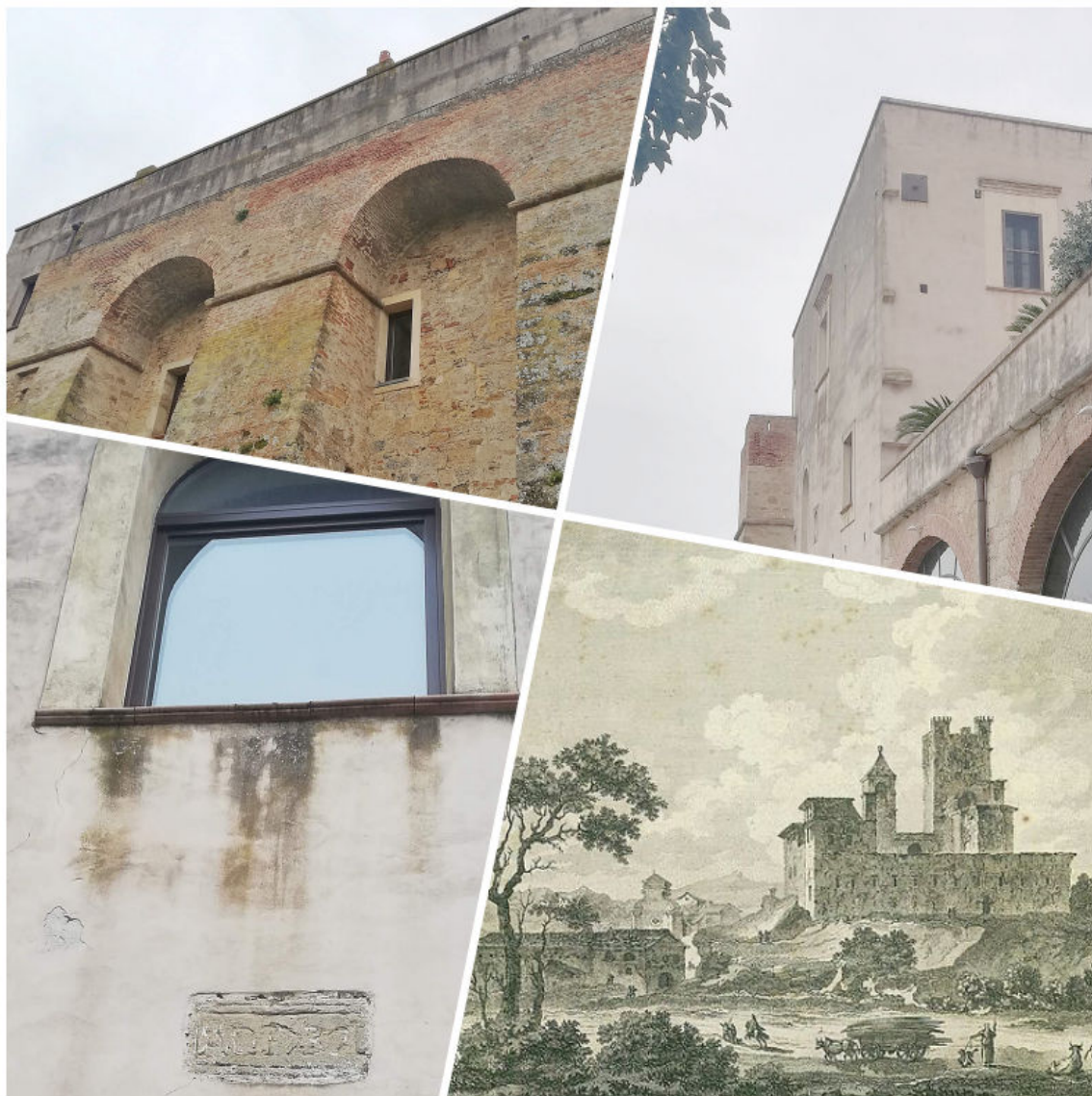
In alto, scarpa di rinforzo in mattoni della torre sul lato nord, opera dei Gesuiti (data riportata sul lato della torre A.D.1730). In basso l'alta torre sul lato nord visibile dal Tratturo del Re nella stampa dell'abate Saint Non dimezzata durata l'amministrazione del feudo della famiglia Serra di Gerace
