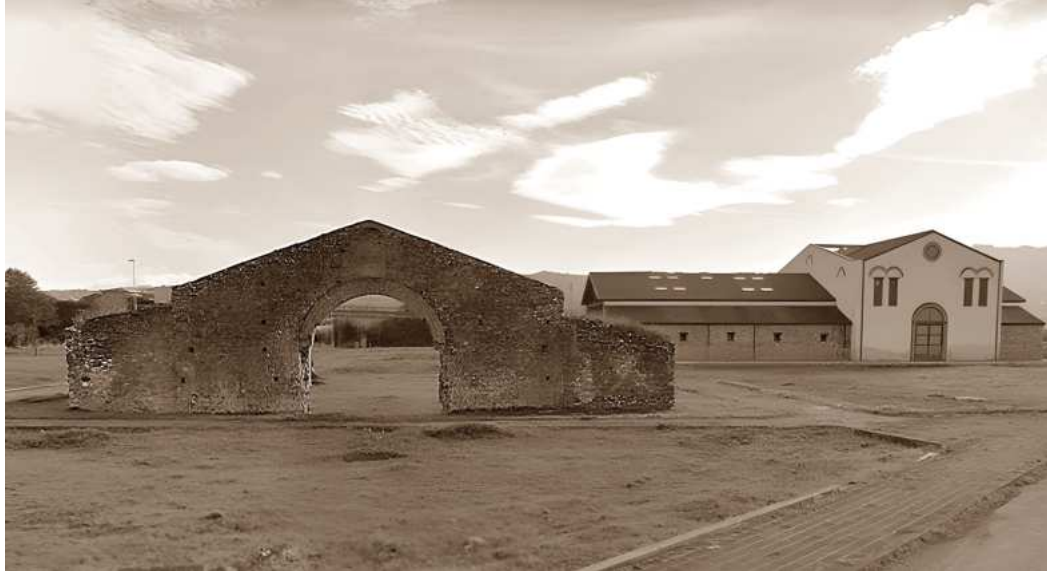
Resti murari della struttura del Mercato di Senise (XV secolo). Sullo sfondo, la struttura del nuovo Mercato
