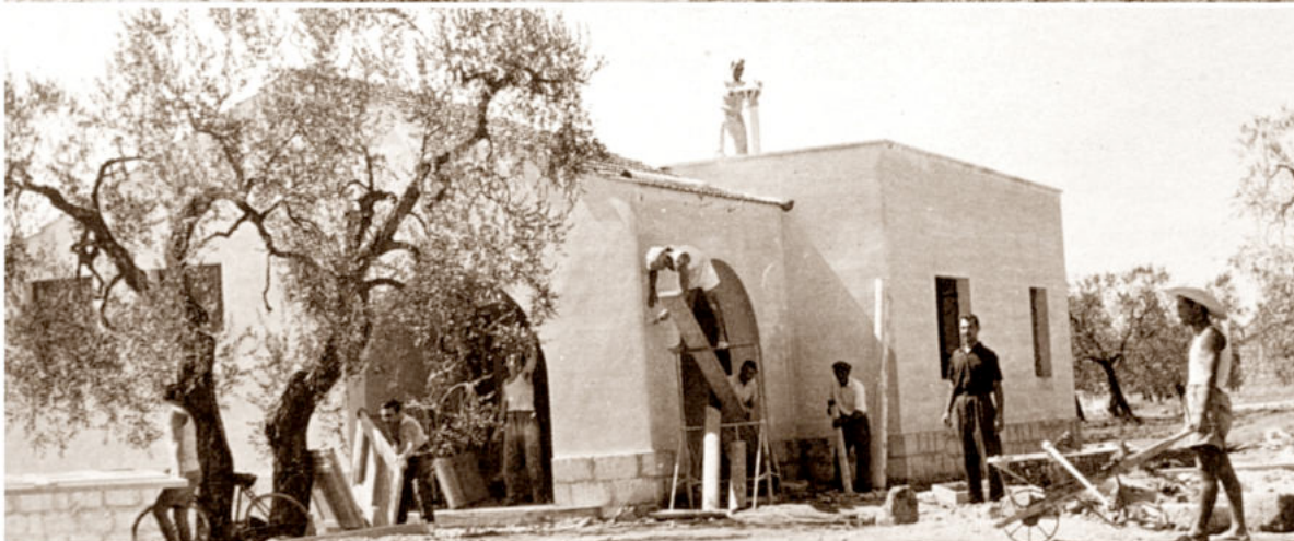
Fase di costruzione della Piazza Eeraclea, centro della Riforma Fondiaria. In basso, costruzione di casa colonica nell'agri di Policoro
