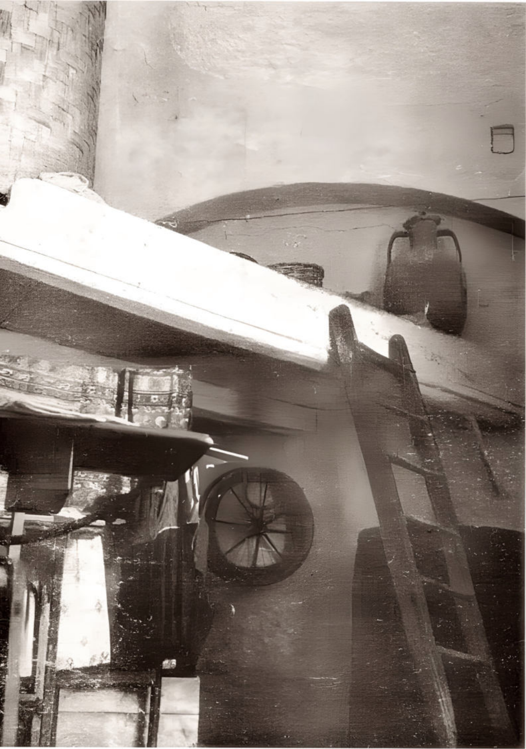
Inchiesta Ambrico, Op.cit. L'interno di un lammione, visto dal basso, con la scala a pioli per salire sul tavolato, sul quale è visibile il cestone per stivare il grano
