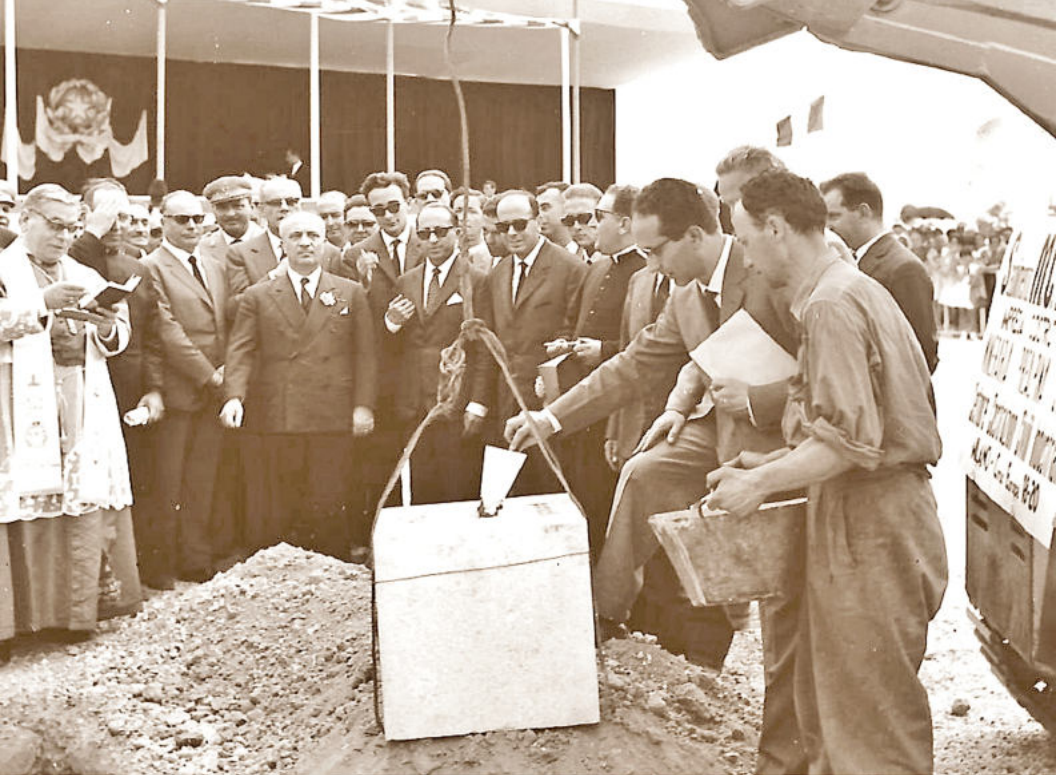
Posa della prima pietra Manifattura Ceramica Pozzi in Val Basento il 29 luglio 1961 (da G.Volpe, Op.cit.)
