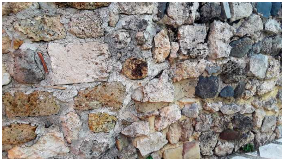
Struttura delle mura a nord nei pressi della Porta di Capo o Porta Melfi con pietre grezze vulcaniche, tufacee e arenaria, con malta e cocci
